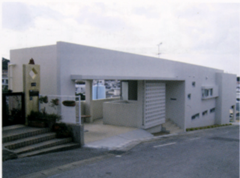
北側外観。傾斜地に立つ
